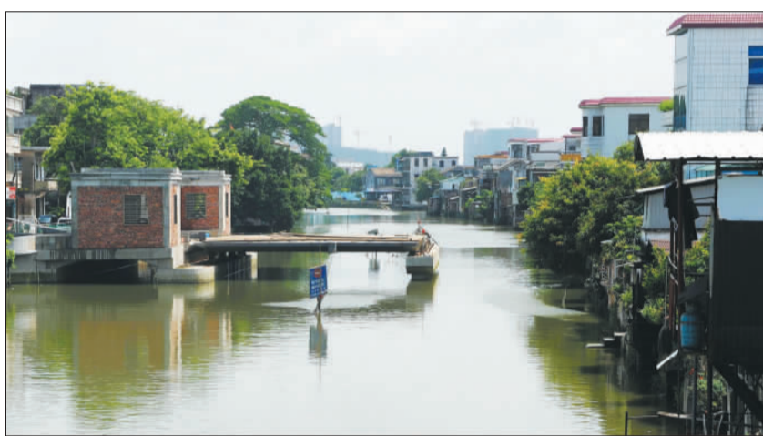
18日下午,记者看到,新的西街大桥建到一半便已停工。
